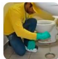
Banheiros / Instalações sanitárias
